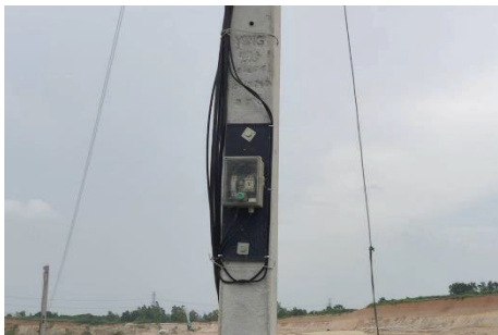
รูปที่ 2-33: อุปกรณ์ส่งสัญญาณเตือนก่อนการระเบิด
